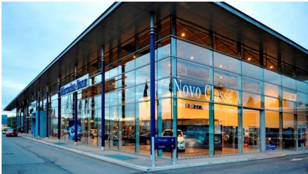
Figura 5 - Instalações da empresa, em Guimarães
