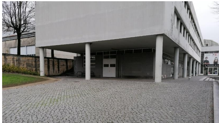
Figura 22 Zona de entrada do Campus de Azurém
