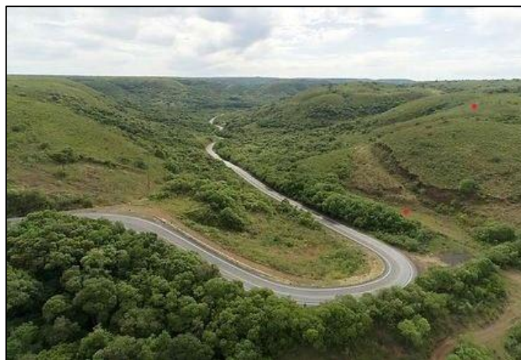
Figura 65. Vista panorámica (aérea) de la escarpa atravesada por la Ruta 30 (Foto: Andrés Benvenuto).
