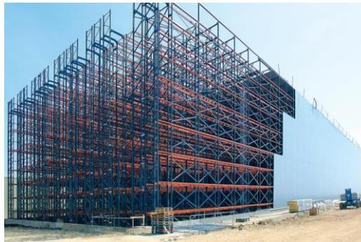
Figura 10 - Autoportantes (Mecalux (b), 2023).
