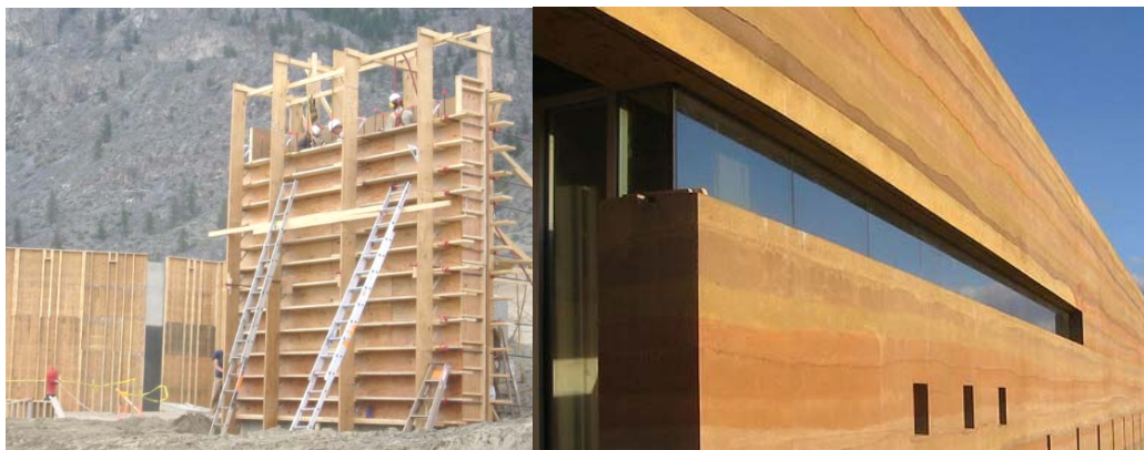
Figura 5 – Construção de parede e edifício em taipa
