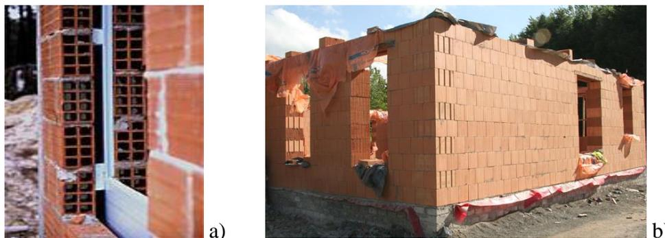
Figura 5: Soluções de paredes de a) preenchimento e de b) alvenaria estrutural. Para quê paredes de preenchimento quando podemos ter paredes resistentes?
