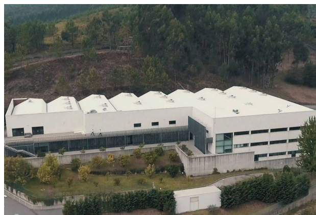
Figura 3 – Instalações do Atelier de Ponte de Lima.
