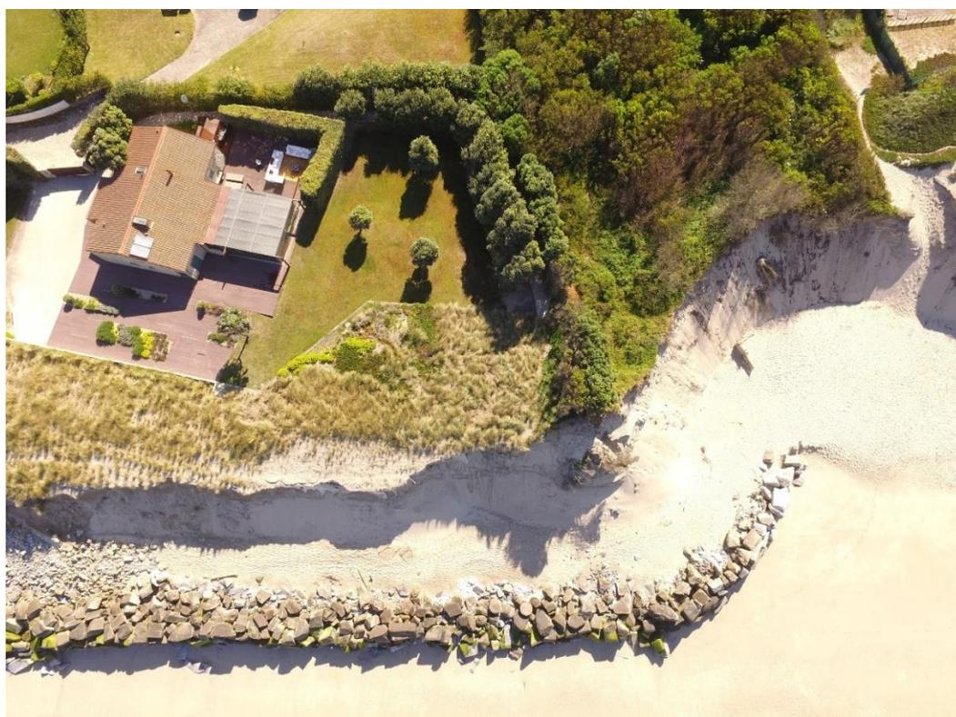
**Figura IV - 16:** Construção em pedra na Praia da Bonança para proteção de habitação.
