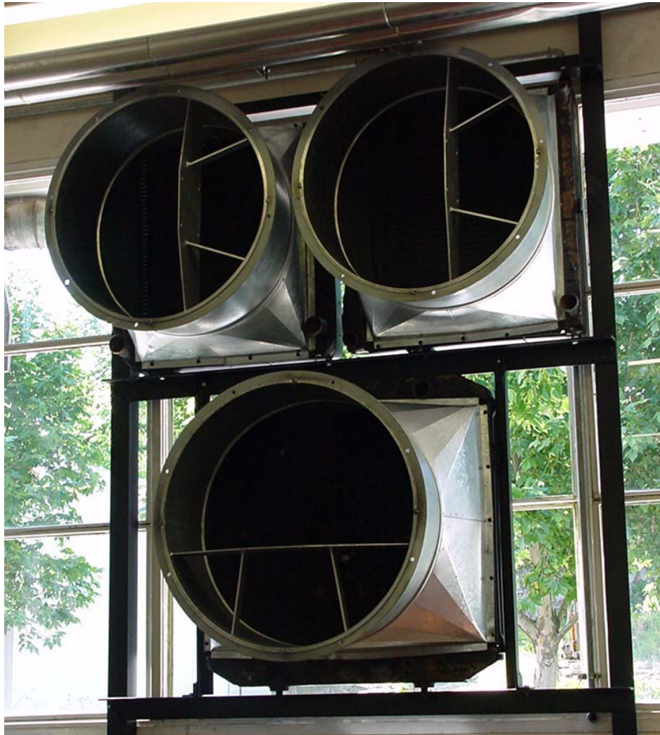
Figura 3.18: Aspecto dos permutadores de calor água-ar, para dissipação do calor produzido na fornalha.
