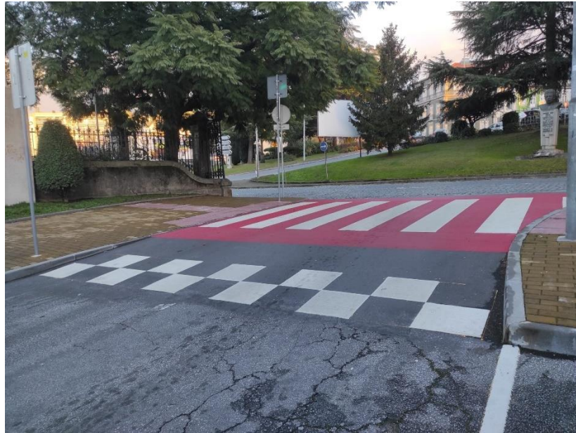
Figura 11 - Travessia elevada em Braga
