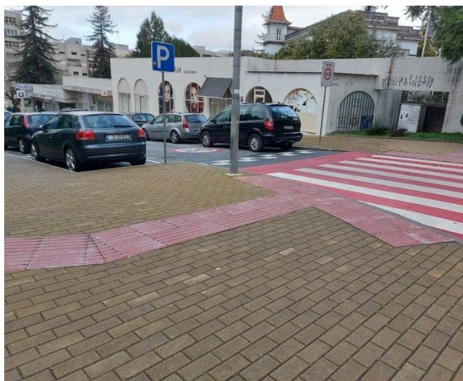
Figura 14 - Pisos táteis no passeio em Braga
