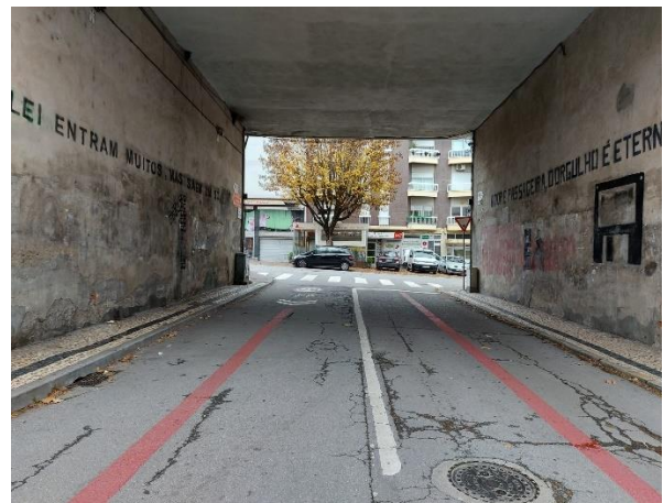
Figura 57 - Túnel Rua Orfeão de Braga
