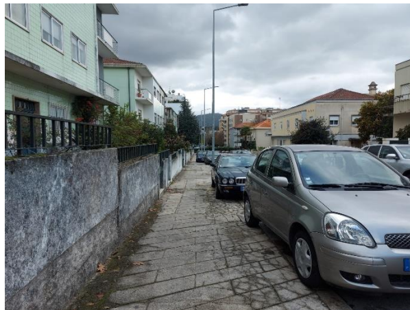
Figura 66 – Invasão no passeio por estacionamento na Rua Bernardo Sequeira
