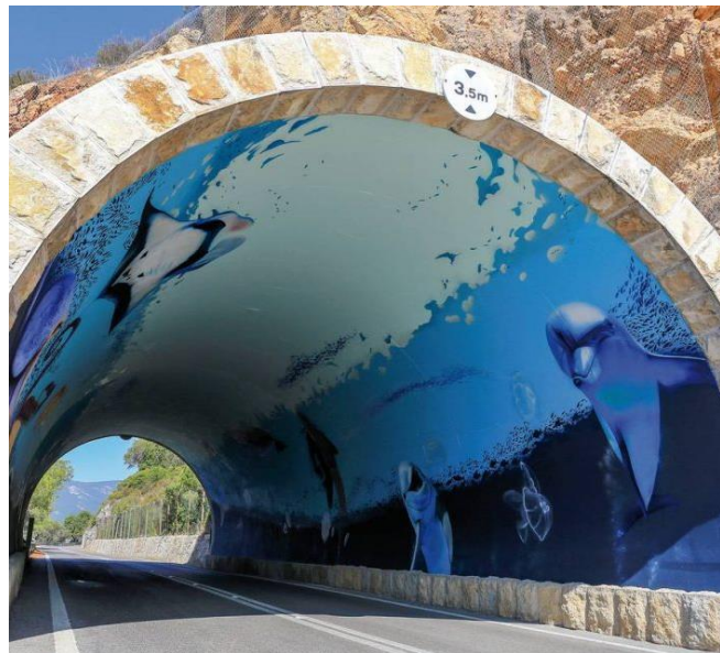
Figura 91 - Túnel com arte urbana em Arrábida (Rosa, 2020)
