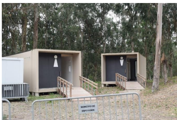
Figura 50 - Casas de banho no exterior do Centro de Interpretação
