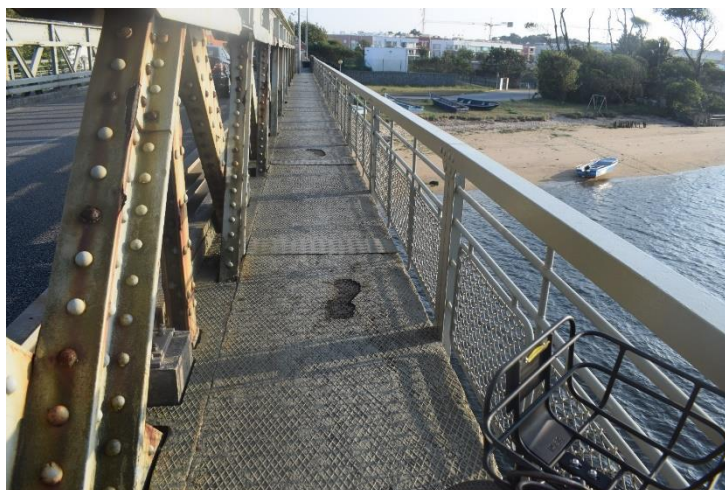
Figura 43 - Ponte Luís Filipe
