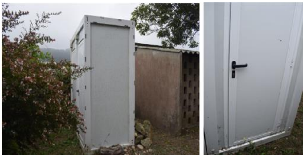
Figura 48 - Casa de banho da Casa das Marinhas
