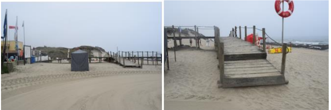
Figura 53 - A praia de Cepães com os passadiços/rampa de acesso à praia/ Obstáculo para as pessoas com mobilidade reduzida
