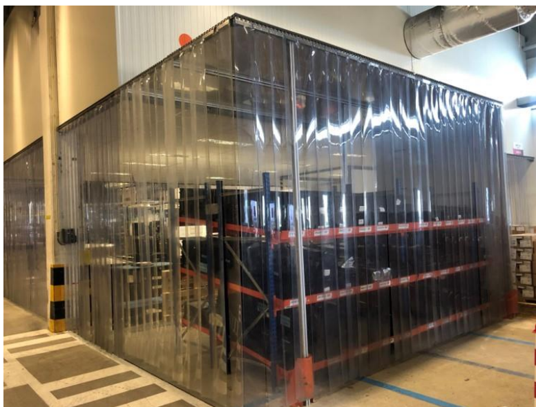
Figura 54: Rampas com caixas para a produção isolada com cortinas ESD
