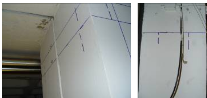
Figura 4 – Exemplos dos locais onde foram efectuados os ensaios nos pilares.
