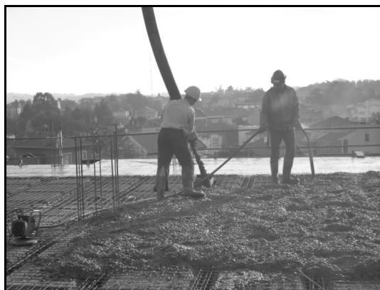
Figura 5 – Betonagem de elemento horizontal (laje aligeirada) com auxílio de uma autobomba.
