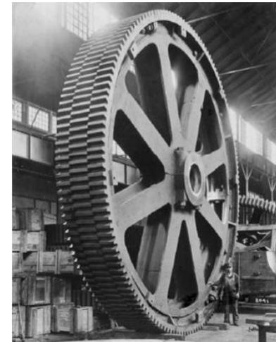
Roda cilíndrica exterior de dentes inclinados de primeira geração
