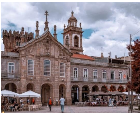
Figura 1 - Edifício da Arcada
