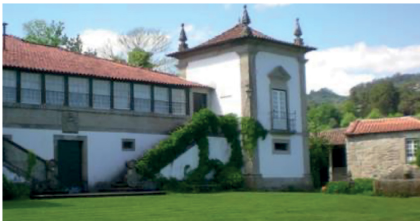
Figura 17 Fachada típica das regiões do Norte de Portugal, com extensas áreas envidraçadas voltadas a Sul para potenciar a captação solar no inverno com varanda orientada a Sul.
