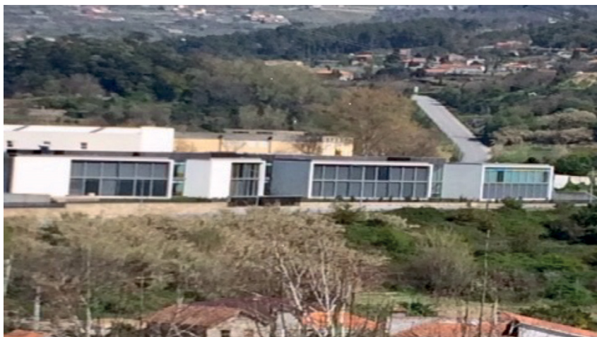
Figura 9 Edifício da Parque escolar em Santa Marinha do Zêzere (Baião) – Excesso de vidro sem sombreamento exterior, o que significa calor no interior sem meios de ser condicionado.
