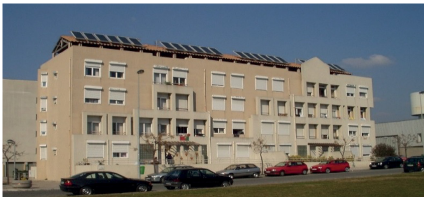
Figura 1 Edifício de habitação social em Vila do Conde, projetado de modo a ter necessidades muito baixas de aquecimento e quase nulas de arrefecimento (Arquiteto Alexandros Tombazis), veio a ser reconhecido com os prémios INH e PLEA (Porto, 1988).
