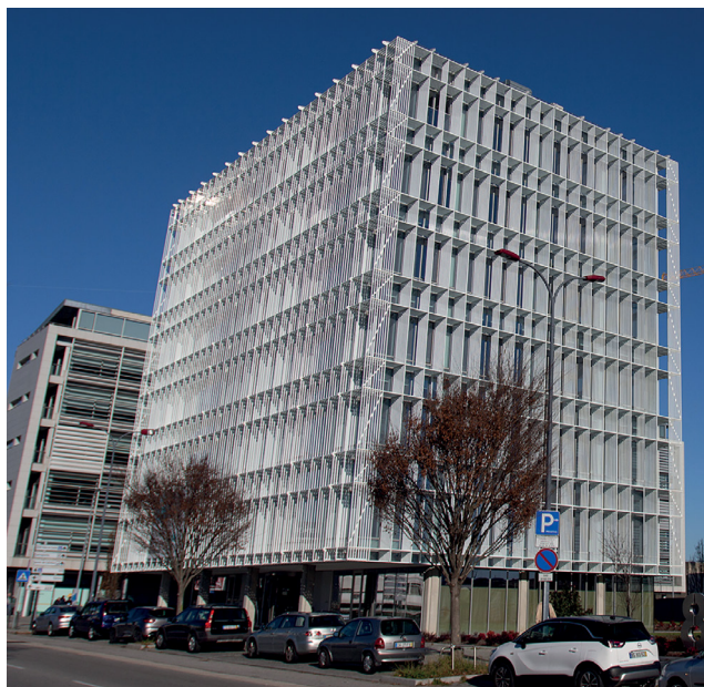
Figura 3 Fotografia de Edifício alheio ao interesse energético nacional em Portugal com suas quatro fachadas indiferenciadas em vidro e displicentemente protegidas com quebra-sóis incorretamente desenhados - Porto, Portugal (2021).
