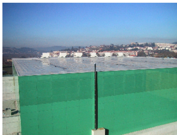
Figura 9.9 – Aspecto de uma parede ventilada com isolamento em espuma de poliuretano e revestimento descontínuo em vidro fixado em estrutura metálica, após a conclusão dos trabalhos
