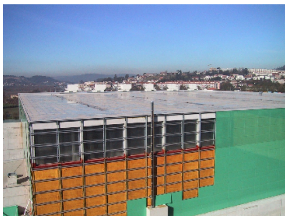
Figura 9.8 – Aspecto de uma parede ventilada com isolamento em espuma de poliuretano e revestimento descontínuo em vidro fixado em estrutura metálica, durante a fase de colocação do revestimento
