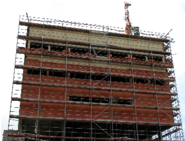
Figura 9.1 – Aspecto de uma parede dupla em alvenaria de tijolo vazado, com espuma de poliuretano preenchendo parcialmente a caixa-de-ar, durante a execução do pano exterior
