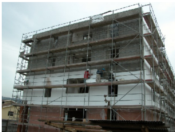
Figura 9.4 – Aspecto de uma parede simples com reboco armado, sobre isolante contínuo pelo exterior, durante a aplicação do isolante
