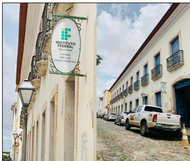
Figura 4 – Fachada do IFMA, Campus São Luís – Centro Histórico
