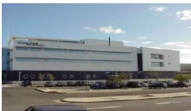
Figura 6 - Centro técnico do Lumiar.
