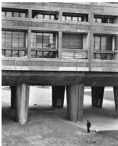
Fig.84. Unidade de Habitação de Marselha, Le Corbusier.
