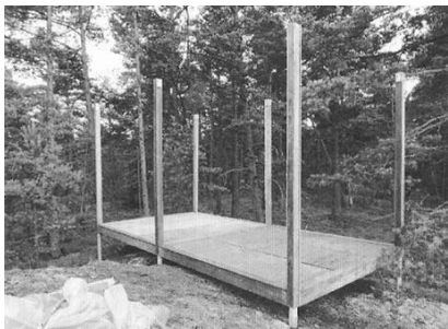
Fig.111. A construção: colocam-se primeiro os pavimentos, para que seja possível caminhar-se de imediato sobre os mesmos, e assim se consigam montar os painéis verticais correspondentes às paredes exteriores e interiores e os tetos. Moduli 225, Juhani Pallasma e Kristian Gullichsen.
