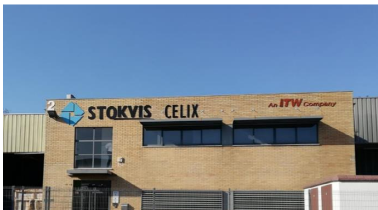
Figura 16- Instalações da Stokvis Celix Portugal Unipessoal, Ltd.
