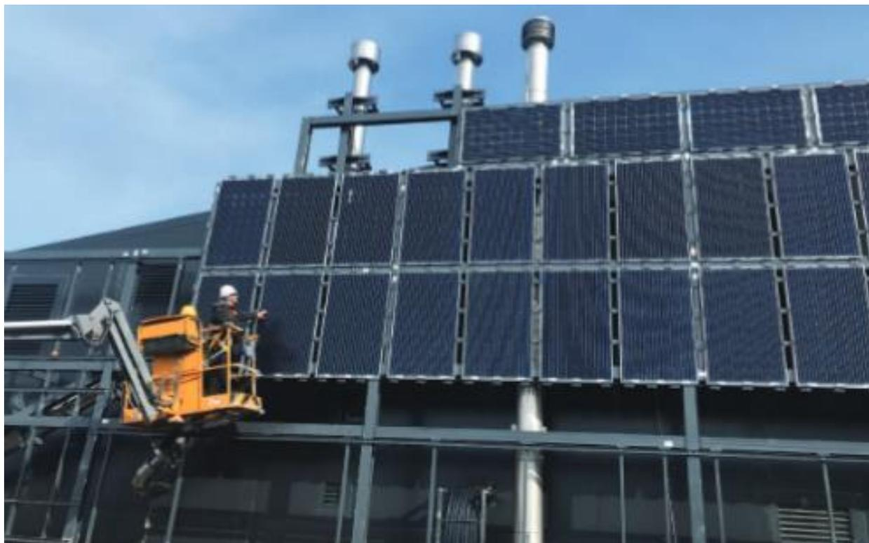
**Figura 25. Posicionamento dos painéis solares**
