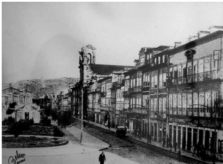
Figura 1 Fotografia da fachada da retrosaria Pereira das Violas exposta em loja, Fábio Marques, 2019
