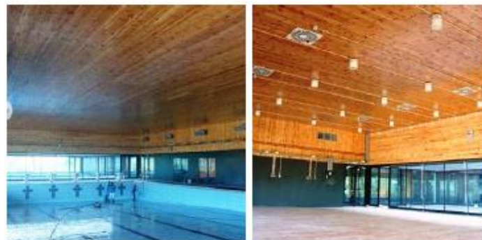
Figura 8 - Complexo Municipal de Piscinas, Almada (Costa, 2013).
