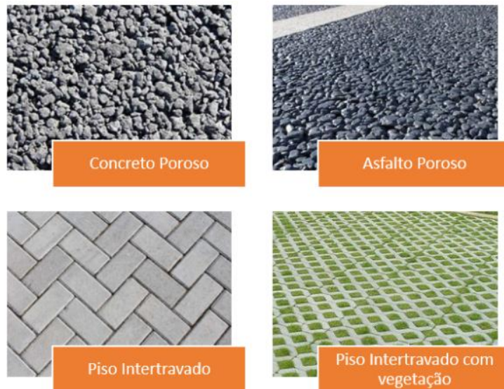
Figura 9: Exemplos de pavimentos permeáveis
