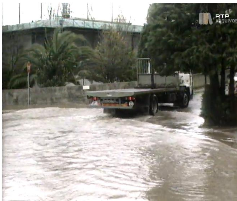
Figura 42: Estragos na zona industrial de Braga Fonte: RTP Arquivos
