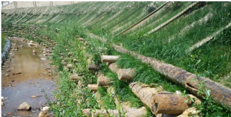
Figura 4: Muro de suporte vivo
