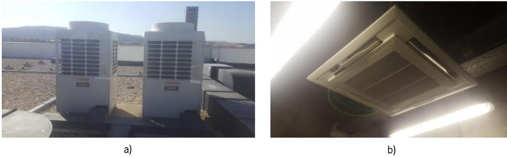
Figura 4.19 – VRV's presentes no HTQ – a) unidades exteriores; b) unidade interior alocada à sala de quadros elétricos piso 3.
