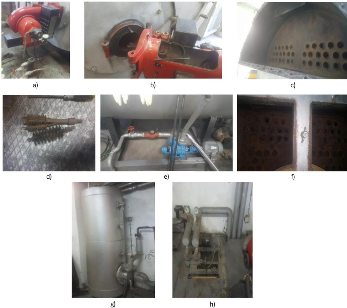
Figura 5.19 – Manutenção preventiva de uma das caldeiras do HSPVR – a) queimador da cadeira 1 com sistema de alimentação e filtro de nafta; b) queimador em manutenção após retirada de eléctrodos; c) tubulares da caldeira após limpeza; d) escovilhões para limpeza de tubulares; e) sistema de alimentação de água da caldeira; f) câmara de inversão de gases; g) depósito intermédio de nafta; h) bomba de parafuso de circulação de nafta.
