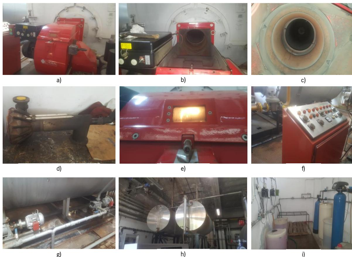
Figura 5.18 – Manutenção preventivas de uma das caldeiras do HSPVR – a) queimador da caldeira 1; b) carcaça do queimador antes de limpeza; c) tubo de fornalha (1ª passagem de gases); d) queimador de injeção com os respetivos elétrodos de ignição; e) teste efetuado após afinação do queimador; f) quadro de comando da caldeira; g) sistema de bombagem de água; h) depósitos de condensados; i) descalcificadores de água (inativos).
