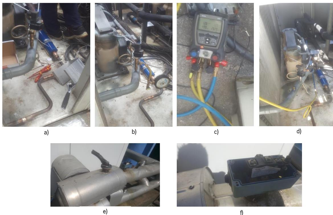
Figura 5.17 – Manutenções preventiva e corretiva do *chiller* do CHSJ – a) troca de filtro secador da linha do fluido frigorigéneo (a azul); b) ensaio de estanqueidade com azoto à linha de fluido; c) RMM da secção 5.1.6 em utilização; d) *retrofit* no circuito de fluido frigorigéneo com a realização da troca de R22 por R417A; e) tubagens de água onde se efetuou a troca do fluxostato; f) fluxostato F61SB-9100 avariado.
