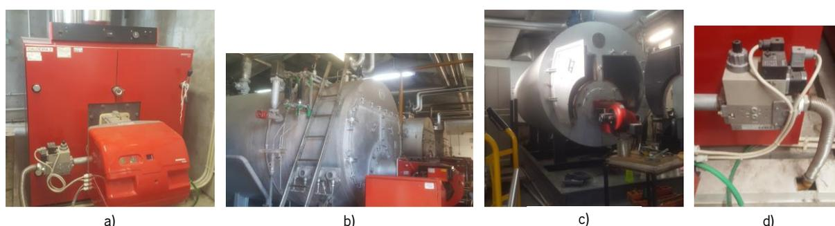
Figura 4.16 – Caldeiras, queimadores e rampas de gás do HTQ, HSPVR e ESEP – a) caldeira BAXI ROCA CPA 460-BTH; b) caldeiras a GN do HSPVR ; c) caldeira a nafta da ESEP; d) rampa de gás.
