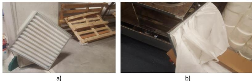
Figura 5.21 – Filtros – a) Filtro G4 após lavagem e desinfecção realizadas; b) filtro de sacos M5 específico para colocação em salas de bloco operativo.
