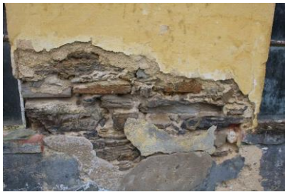
a) Rubble masonry
