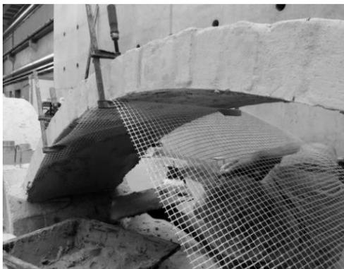
Figura 48 – Aplicação da malha de reforço pelo intradorso.
