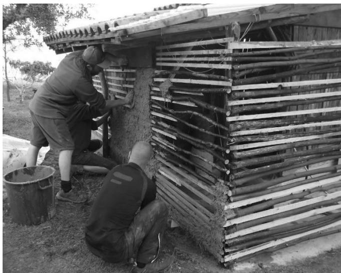
Figura 4 – Construção em tabique (mount-of-oaks.blogspot.pt, acedido em 16/07/2017)
