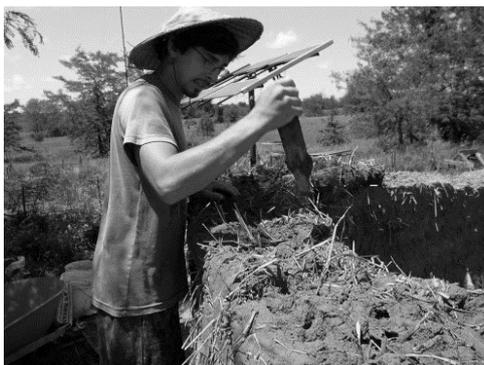
Figura 2 – Construção em terra empilhada ("Cob") ([www.theyearofmud.com](http://www.theyearofmud.com), acedido em 14/06/2017).
