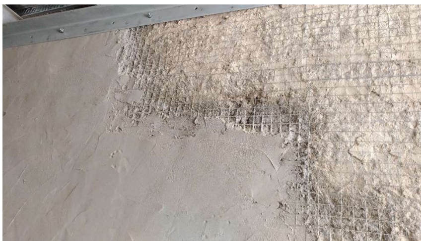
Figura 18: Regularização de paredes com aplicação de malha de reforço (obra de reabilitação no centro da Cidade do Porto, realizado pela empresa BGM, Engenharia e Construção)
