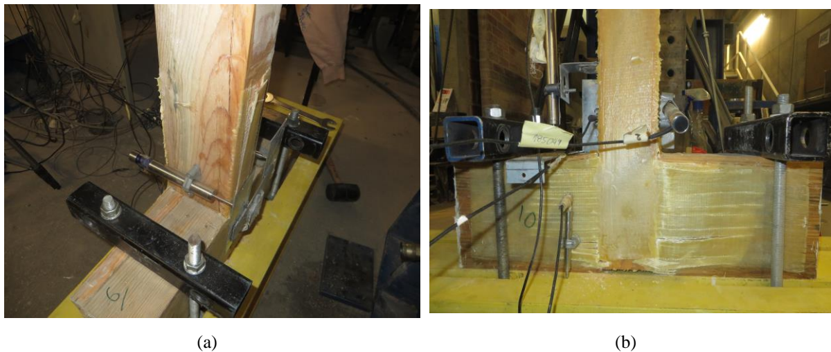
Figura 5.19 -Fotografias de um ensaio pull-out numa ligação reforçada e o comportamento do reforço ao longo do ensaio: (a) cedência da cola epoxy e descolamento do reforço na parte de trás da ligação; (b) deformação/rutura da fibra de vidro na parte frontal da ligação
