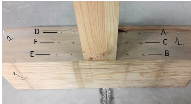
Figura 3.35 – Localização dos furos feitos para a medição do teor de humidade interno.
