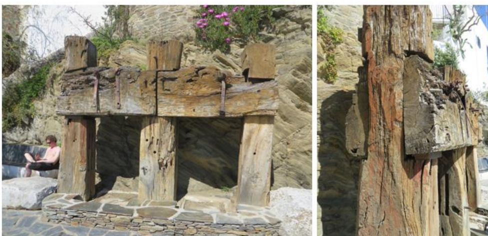
Figura 2.13 - Fotografia de ligações de uma estrutura de madeira e das suas ligações.
