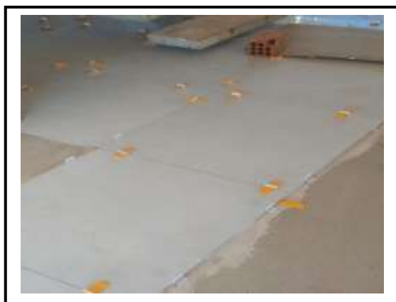
Figura 8: Assentamento cerâmico
