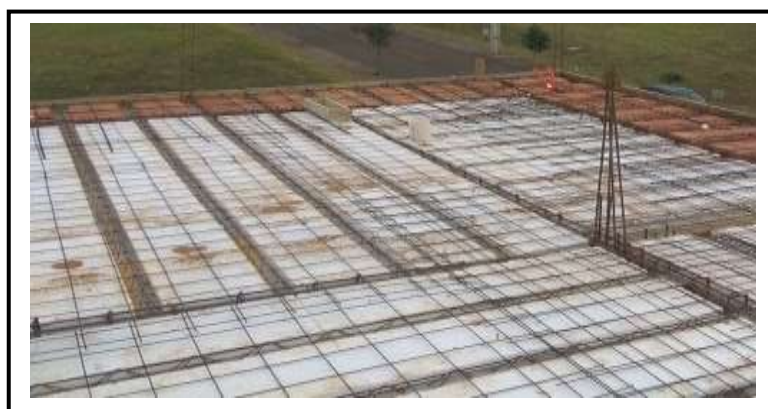
Figura 6: laje de uma residência
