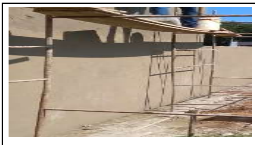
Figura 4: Aplicação da massa (Reboco)
