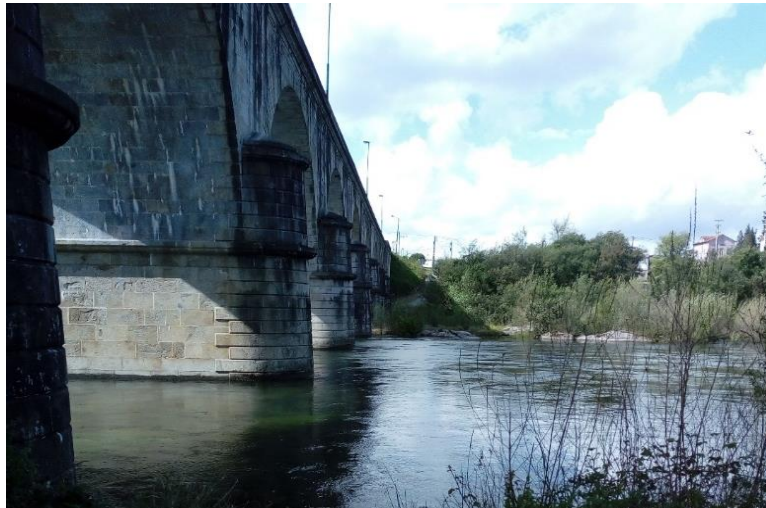
Figura 4.3. Ponto A2 - Montante da Ponte do Bico, em Palmeira, Braga.
