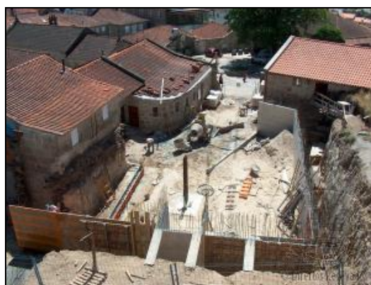
Obras no Núcleo Sede do Ecomuseu de Barroso
