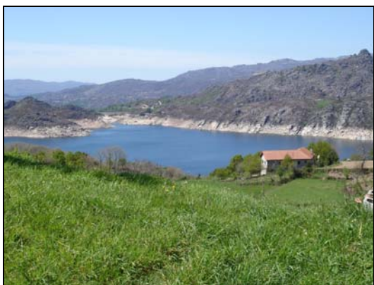
Barragem de Paradela
