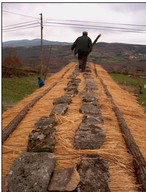
Colmar do Pisão – Paredes do Rio
