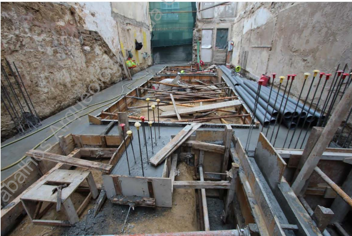
Foto 22 – Acompanhamento do assentamento do betão do novo edificado.
