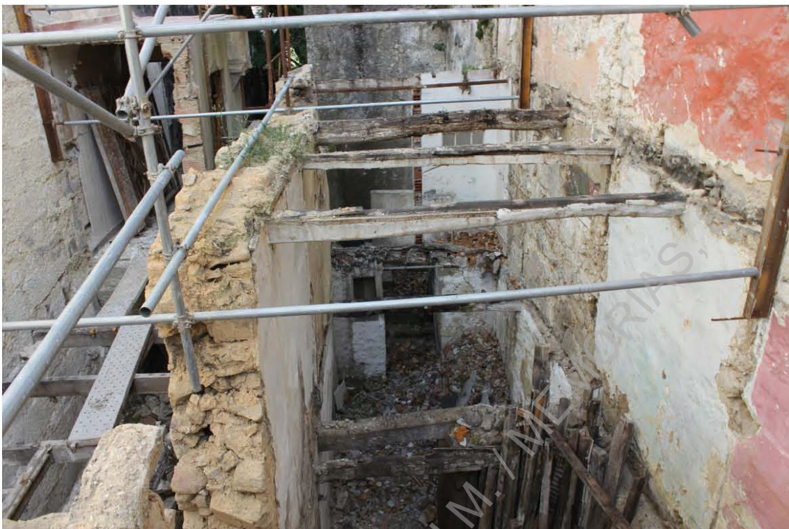
Foto 2 – Acompanhamento dos trabalhos de demolição do edificado.
