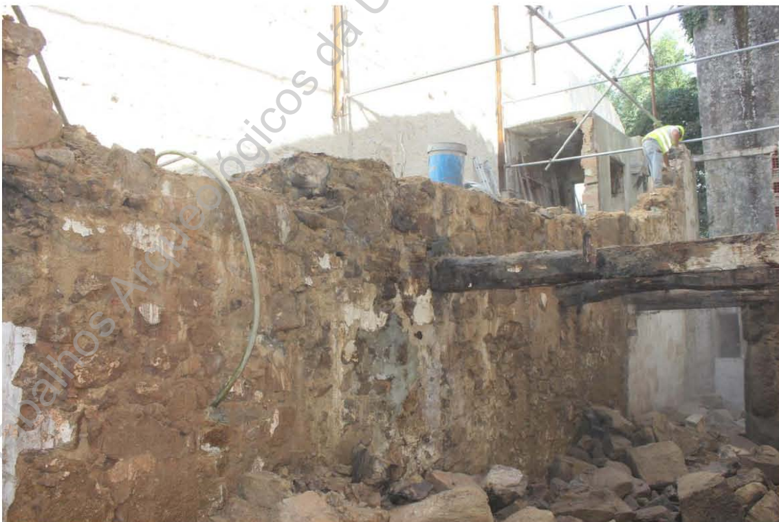
Foto 3 – Acompanhamento dos trabalhos de demolição do edificado.
