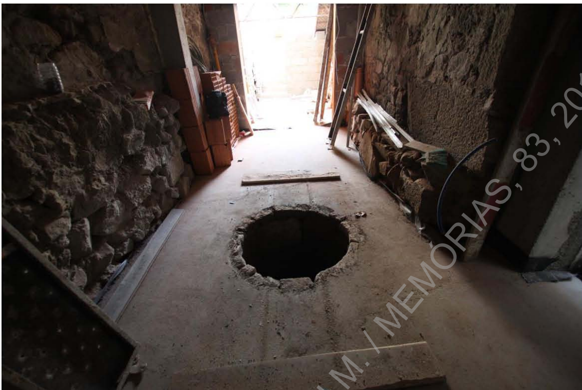
Foto 23 – Estrutura para proteção do poço.
