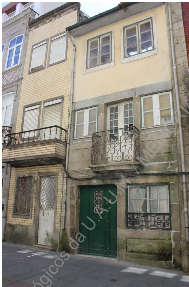
Foto 1 – Fachada da Rua de S. Vicente n°s 84-86.
