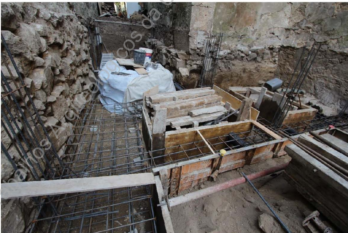
Foto 19 – Manta geotêxtil e estrutura para a preservação do poço UE003.
