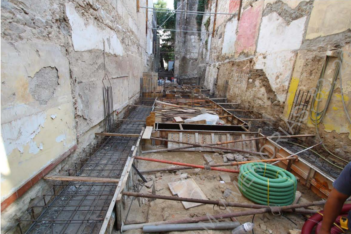
Foto 21 – Acompanhamento da implantação das estruturas do novo edificado.
