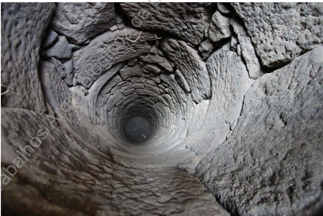
Foto 13 – Alçado interno do poço UE003.
