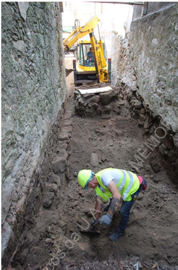
Foto 4 – Acompanhamento dos trabalhos de remoção de terra.
