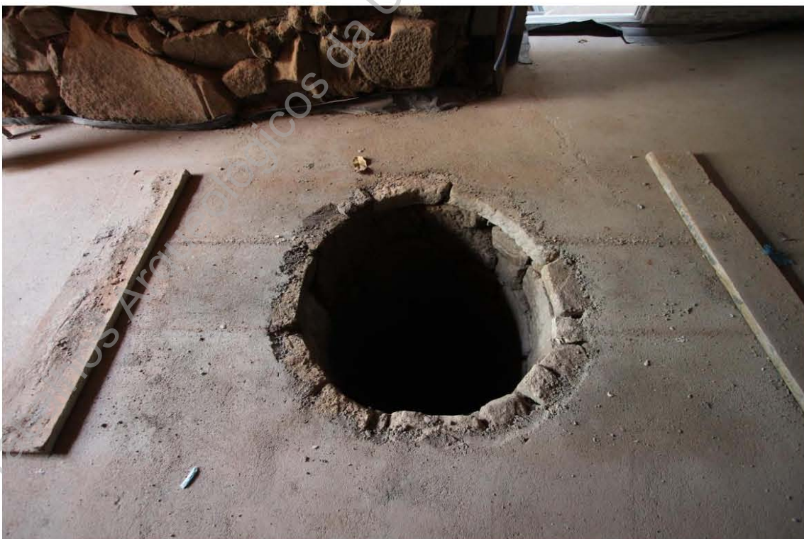
Foto 24 – Estrutura para proteção do poço.
