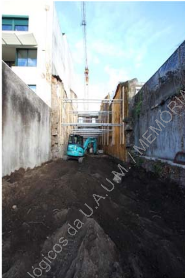
Foto 2 - Acompanhamento dos trabalhos de remoção de terras.
