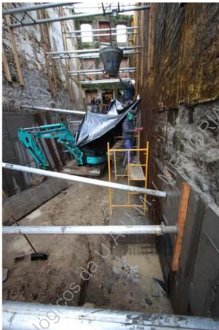
Foto 124 – Acompanhamento da implantação das placas de betão nas paredes do edificado.
