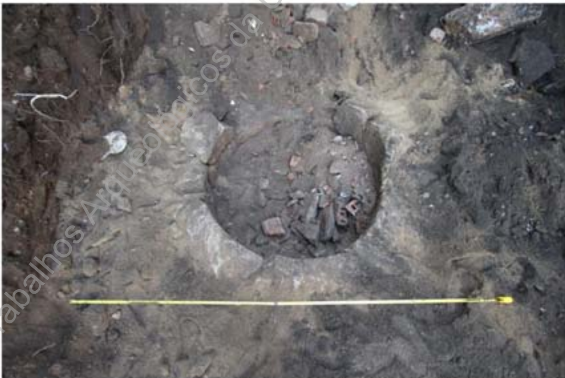
Foto 8 – Registo do poço UE013 com entulho no início dos trabalhos.
