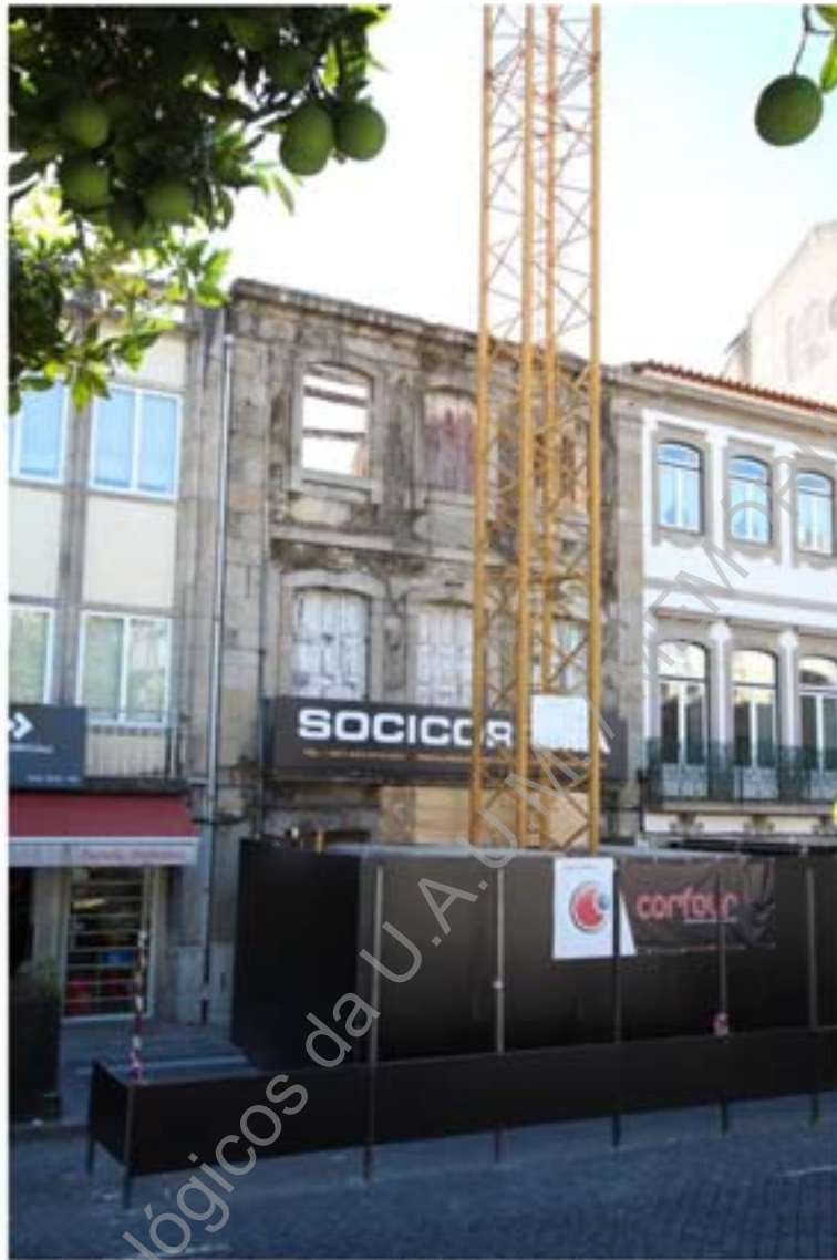
Foto 1 – Fachada do edifício nº 126-128 do Largo Senhora a Branca.
