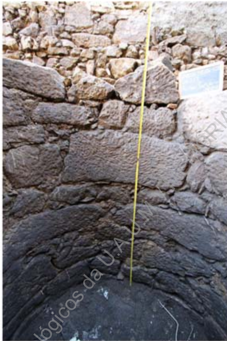
Foto 10 – Alçado interno do poço UE013.
