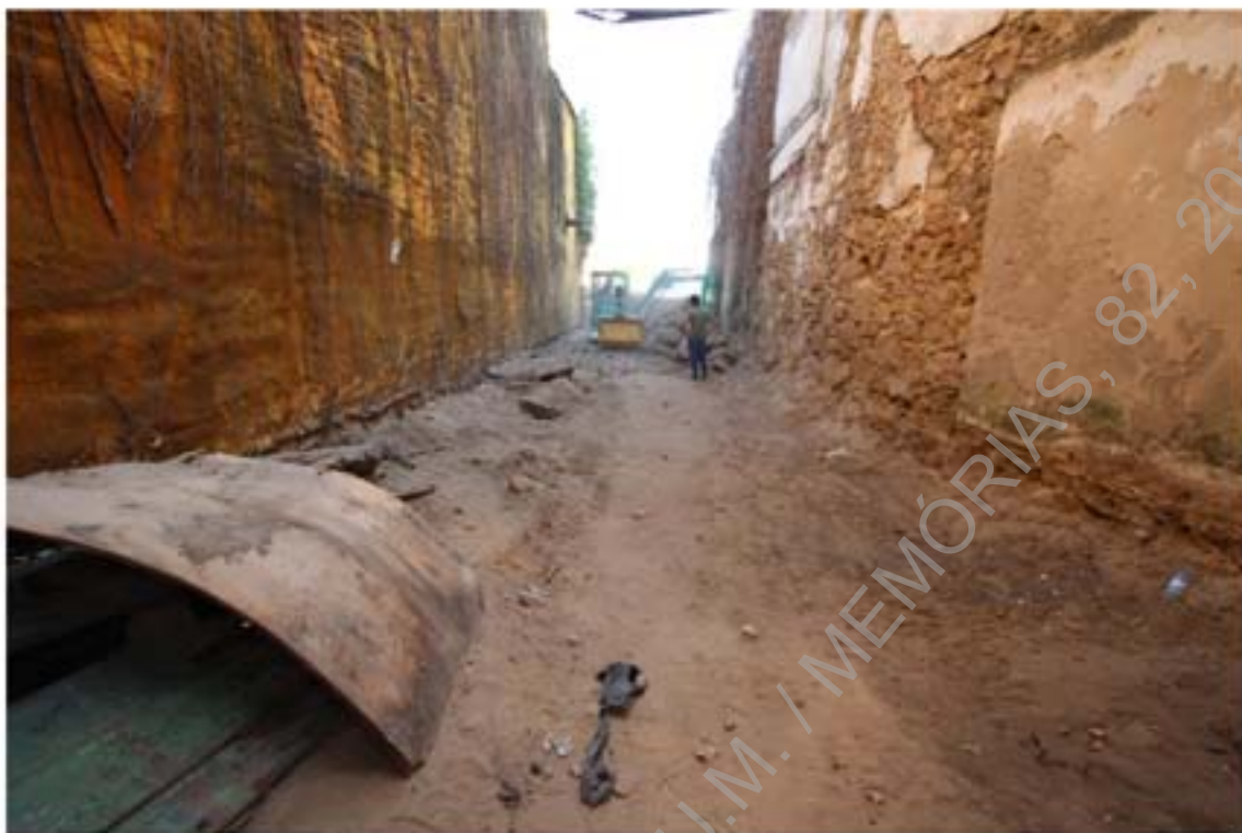
Foto 3 – Acompanhamento dos trabalhos de remoção de terras.
