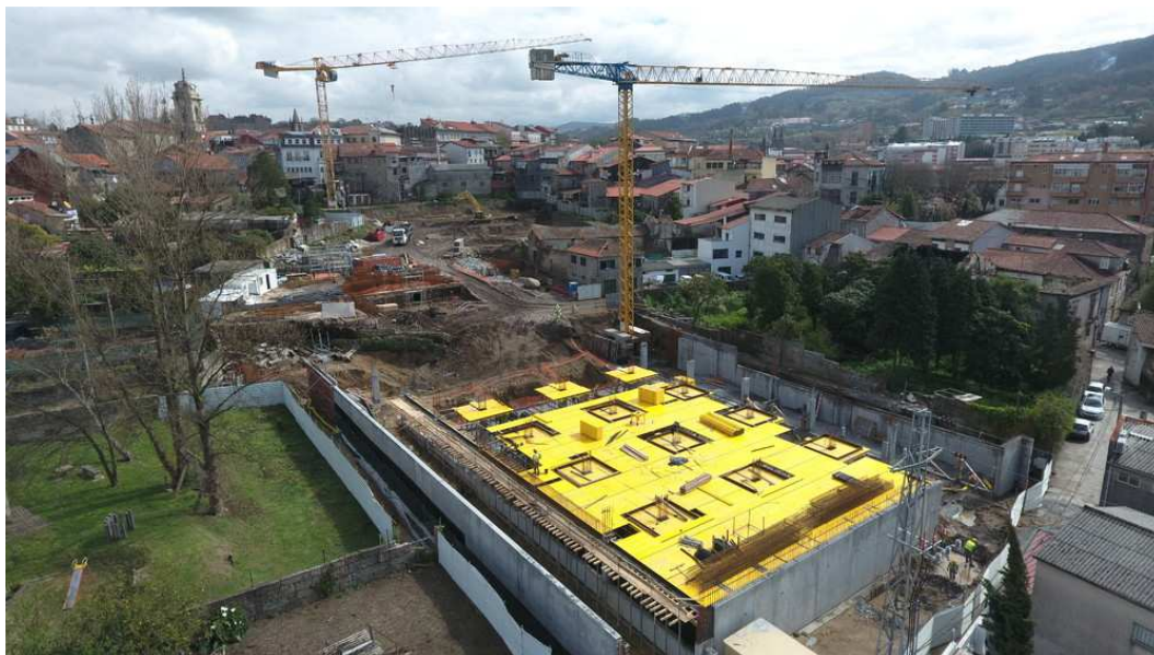
Figura 32: Parque de Estacionamento de Camões – Obras a Decorrer Fonte: Guimarães Digital de 26/04/2018
