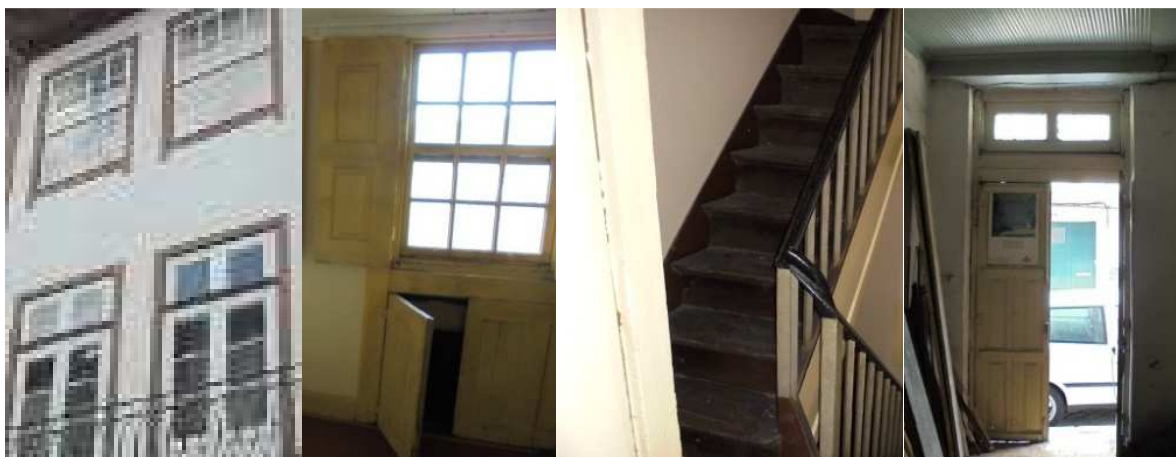
Figura 41: Casa a Reabilitar na ARU do Centro da Cidade
