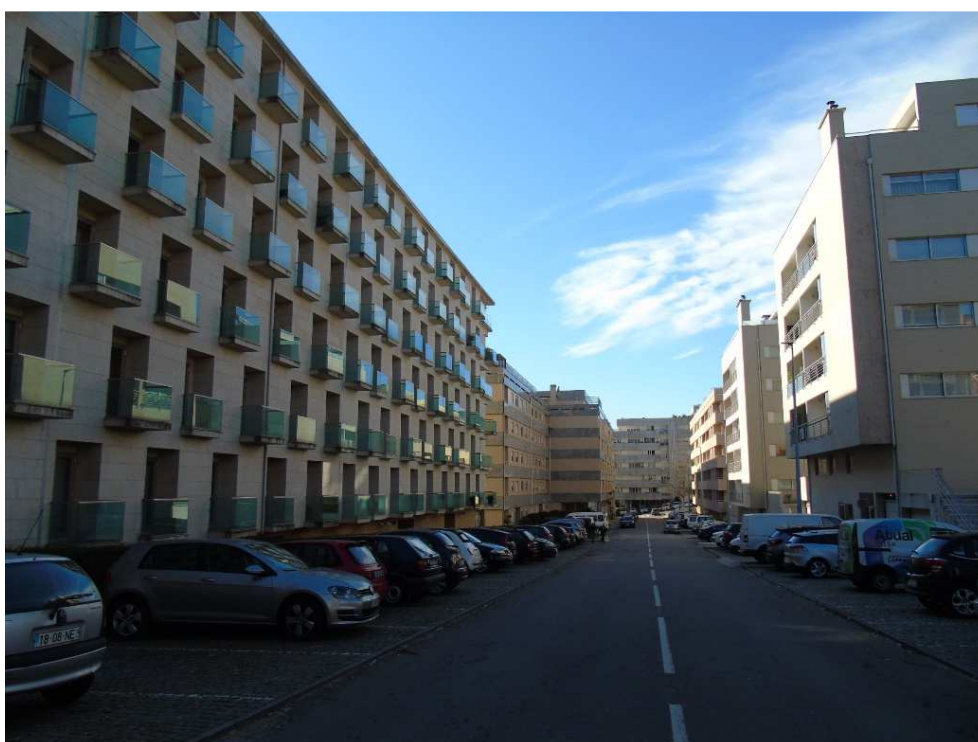
Figura 28: Rua Eça de Queirós
