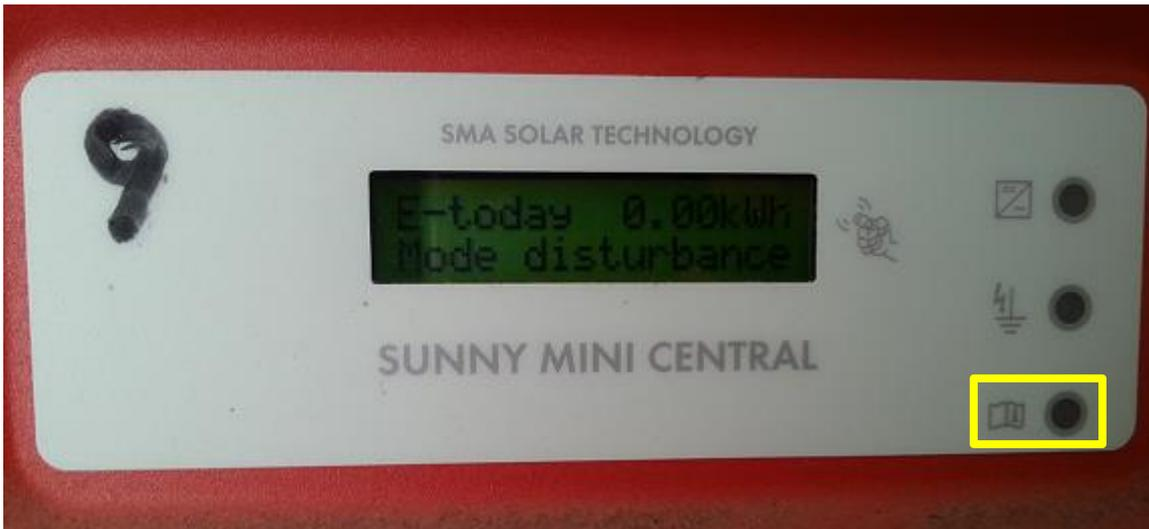
Figura 40 - Mostrador de um dos inversores CC/CA
