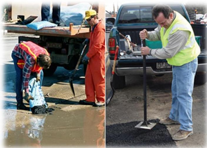
Figura 2.1 – Aplicação de misturas betuminosas a frio na reparação de pavimentos (Adaptado de UPM (2016))
