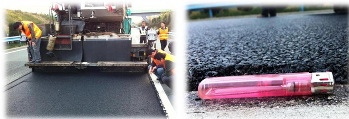
Figura 2.2 – Exemplo de aplicação de microaglomerado betuminoso a frio (adaptado de Go Green (2012))
