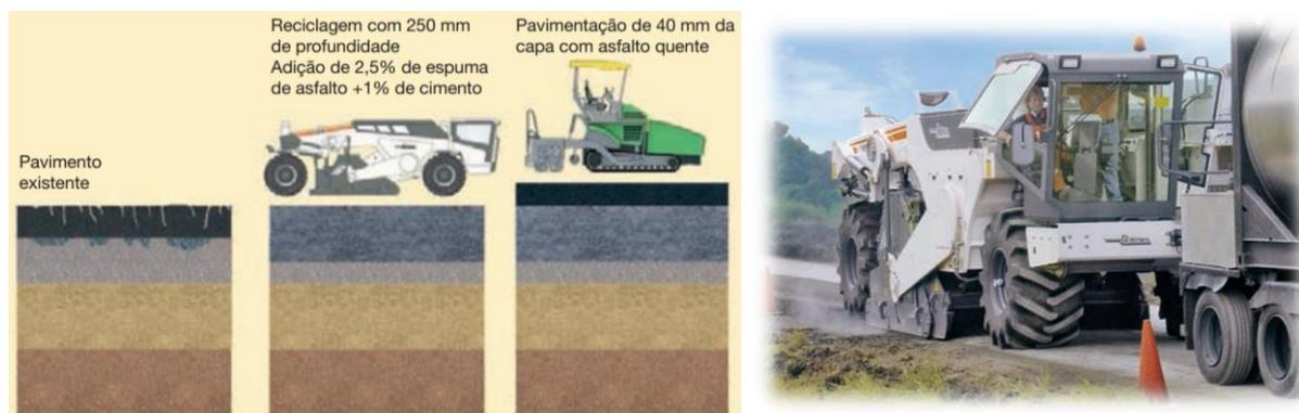
Figura 2.5 – Exemplo de reciclagem profunda do pavimento utilizando técnicas a frio *in situ* (adaptado de Wirtgen (2012))
