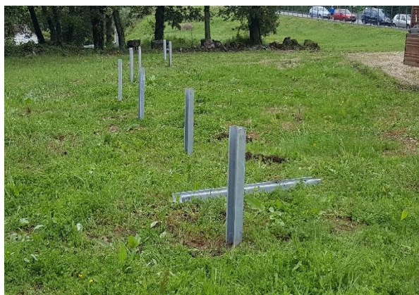
a) Prumos cravados no solo orgânico
