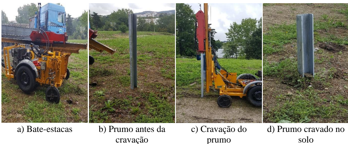
Figura 35 - Procedimento realizado para a cravação dos prumos C 125 no solo
