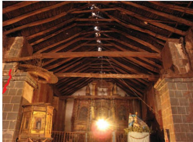
Figura 3: Pilares no interior da igreja junto das parede longitudinais da nave [6].
