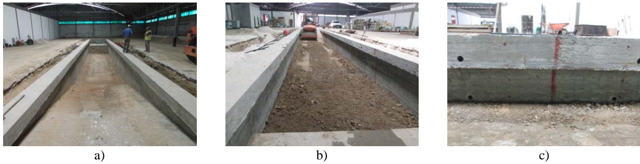
Figura 6: Aplicação das camadas de fundação em solo: a) topo da 1ª camada de 30 cm; b) compactação de camada intermédia de 15cm; c) topo da última camada
