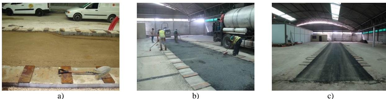
Figura 5: a) Transição de solução solo-cimento 30 cm vs 15 cm + 15 cm; b) Aplicação da solução de RSD; c) Estrutura final com todas as soluções aplicadas
