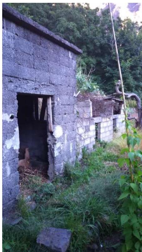
Fig. 96 - Construção em alvenaria de tijolo de betão.
