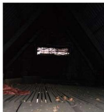
Fig. 34 - Laje em ripado de madeira vista do caniço.
