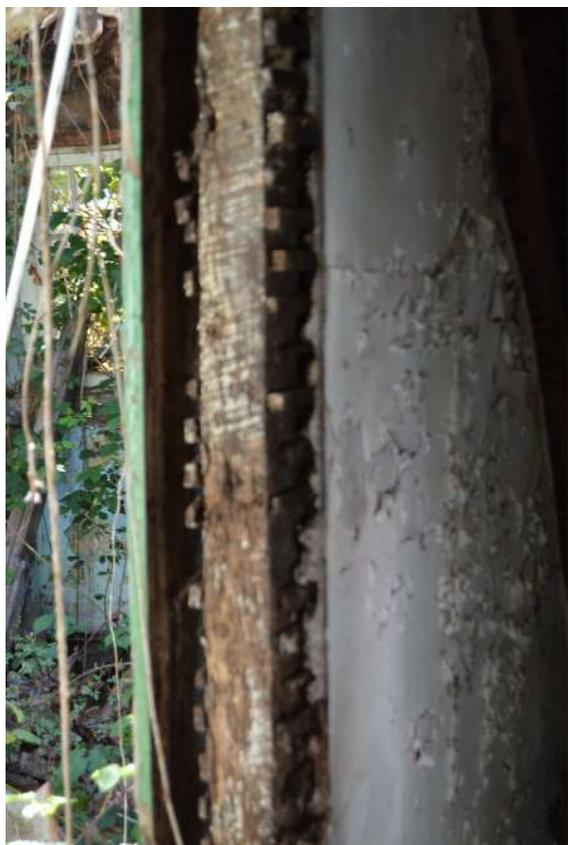
Fig. 97, 98 - Construção em tabique com acabamento em cal.
