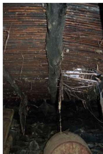
Fig. 33 - Laje do caniço em canas.
