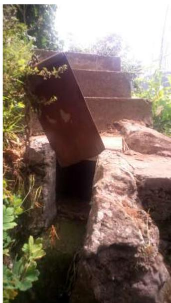
Fig. 20 - Método de desvio das águas.
