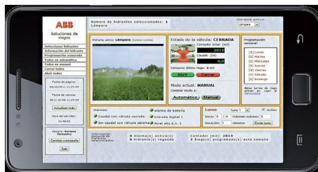
Figura 1 - Interface SCADA - ABB [2].
