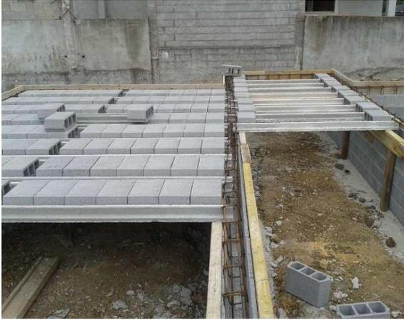
Figura 31 – Início da execução da laje
