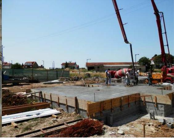
Figura 32 – Betonagem da laje
