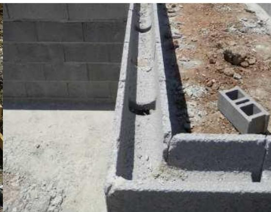
Figura 30 – Colocação de bloco lintel
