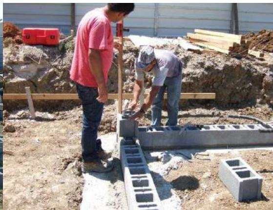
Figura 28 – Nivelamento e alinhamento de fiadas
