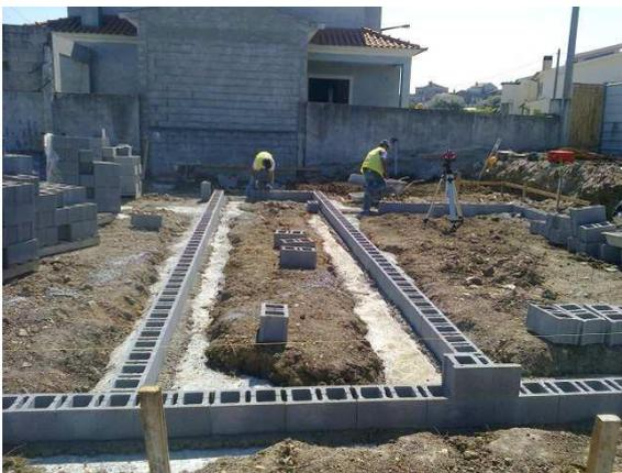
Figura 27 – Início da execução de fiadas de bloco
