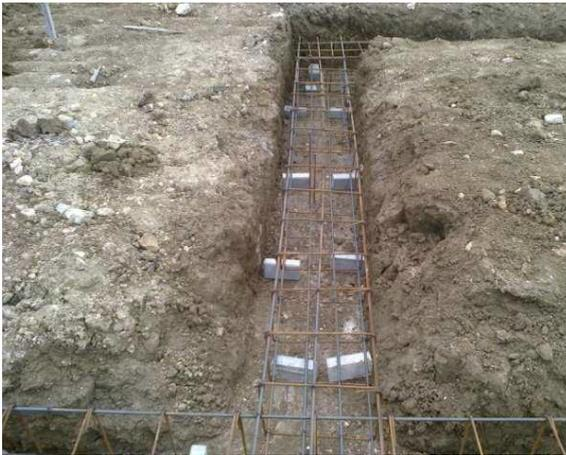
Figura 25 – Colocação de armaduras nas sapatas
