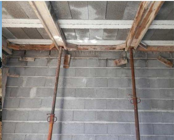
Figura 34 - Aspeto interior depois da betonagem da laje
