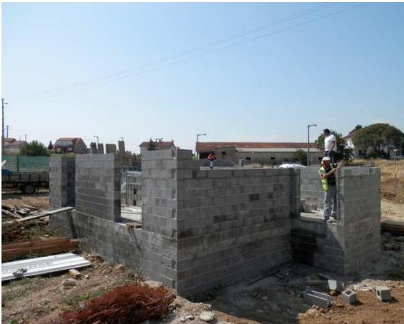
Figura 33 - Processo de execução das paredes
