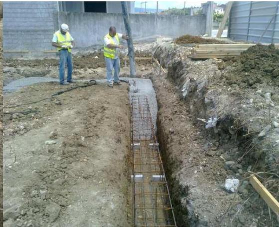
Figura 26 – Betonagem de fundação
