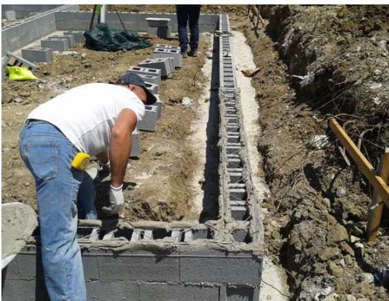
Figura 29 – Colocação de argamassa e armaduras de junta
