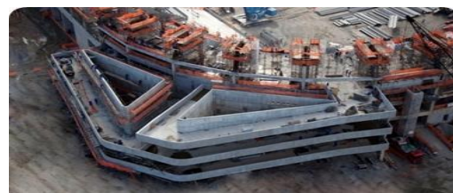
Figura 4. Rampas de acesso.
