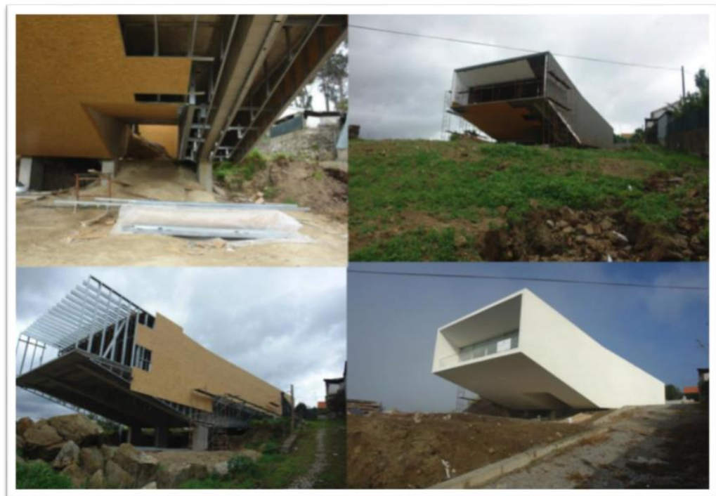
Figura 13 - Construção em LSF, Penafiel 2008 (Fonte: Santos, Almeida & Osório, 2014)
