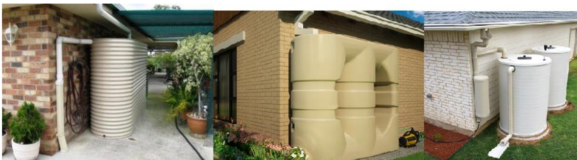
Figura 5 - Reservatórios domésticos superficiais
