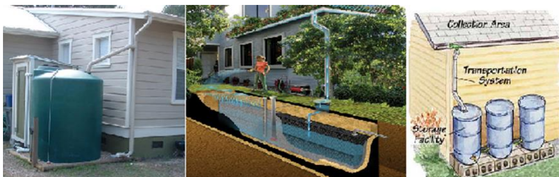
Figura 3 - Tanques de armazenamento de águas pluviais
