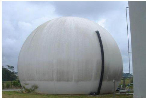
Figura 13. Fotografia do gasómetro da ETAR do Ave.
