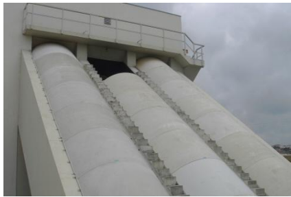
Figura 5. Fotografia do segundo estágio da elevação inicial – parafusos de Arquimedes – da ETAR do Ave.
