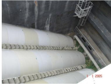
Figura 4. Fotografia do primeiro estágio da elevação inicial – parafusos de Arquimedes – da ETAR do Ave.
