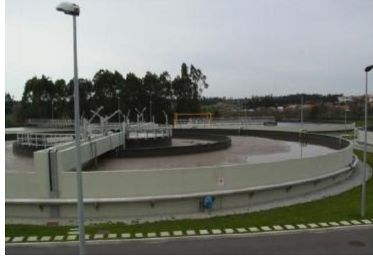
Figura 8. Fotografia do reator biológico da ETAR do Ave.
