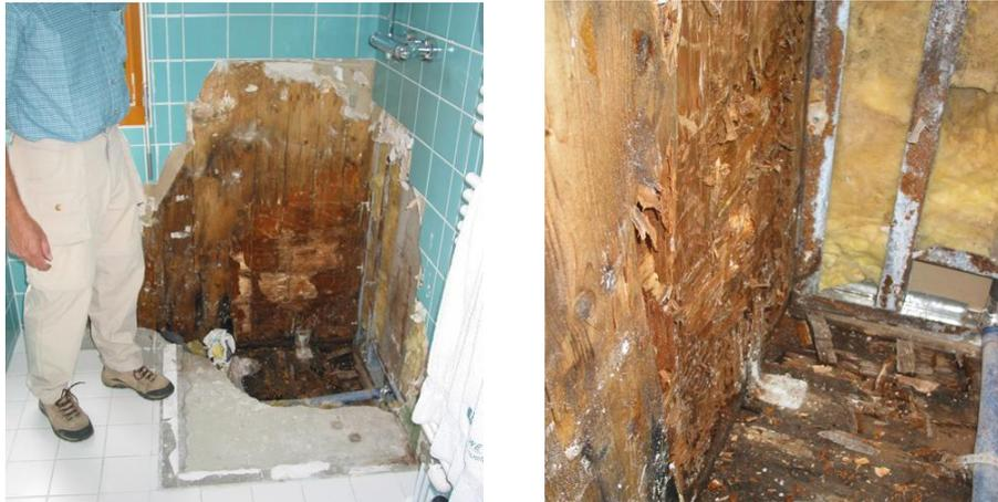
Imagem 34 – Danos na Estrutura de MLCC causados pela Infiltração de Água <sup>32</sup>
