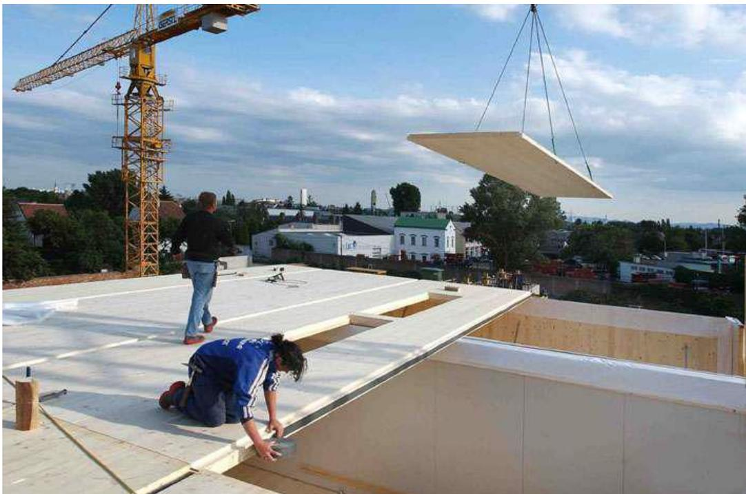
Imagem 44 – Colocação de Membrana Acústica entre os Painéis de MLCC <sup>48</sup>
