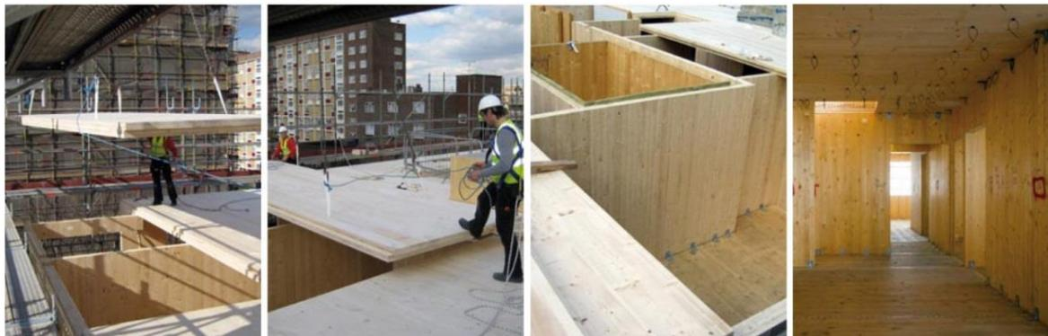
Imagem 14 – Montagem dos Painéis de MLCC no Edifício Stadthaus <sup>19</sup>
